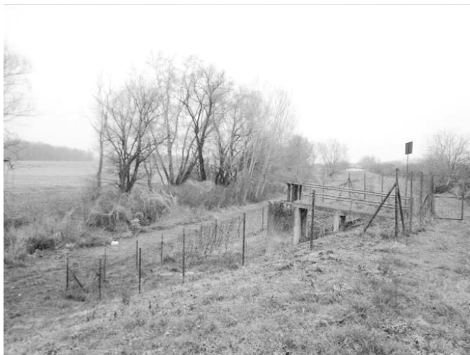
Слика 9 и 10: Цевасти испуст за атмосферску воду са табластим затварачем
