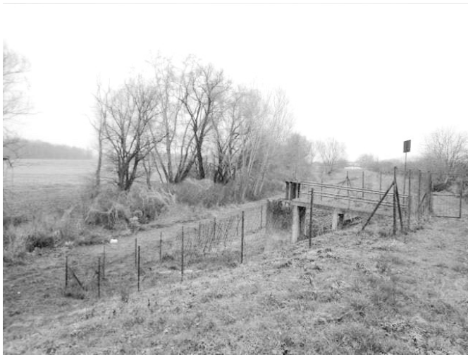
Слика 10 и 11: Цевasti испуст за атмосферску воду са табластим затварачем
