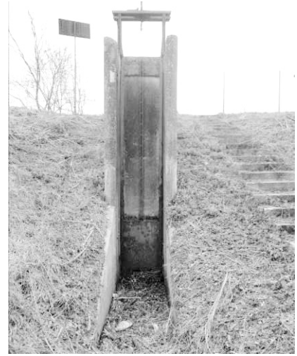
Слика 10 и 11: Цевasti испуст за атмосферску воду са табластим затварачем
