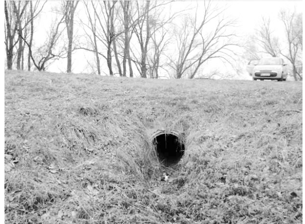
Слика 13: Изглед испуста км 8+181
