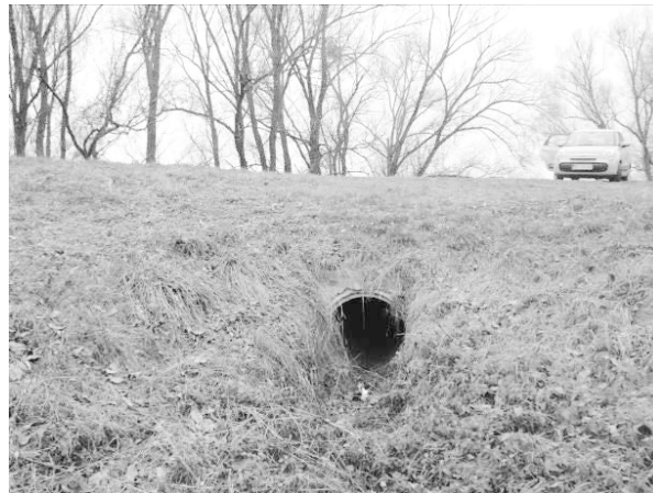
Слика 12: Изглед испуста км 8+181
