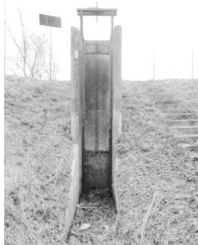
Слика 9 и 10: Цевасти испуст за атмосферску воду са табластим затварачем
