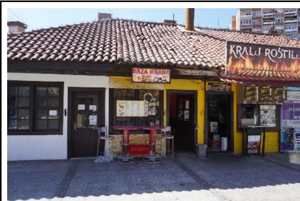
Изглед локала “Брза храна - Frittella” и “Kralj Roštilja”, поглед из правца пешачке зоне - непримерени и предимензионисани изглед рекламе - непримерена боја фасадних равни
