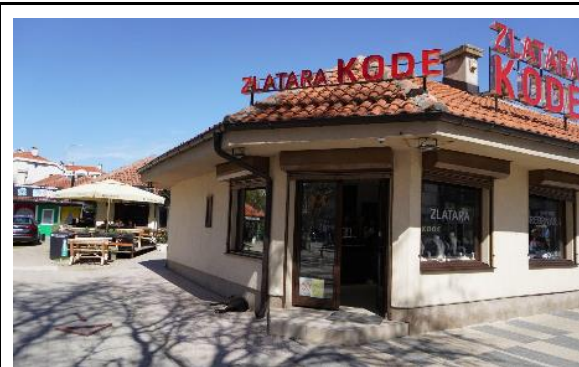
Изглед Занатског центра и локала златара “КОДЕ”, поглед из правца Булеvara Ослобођења
