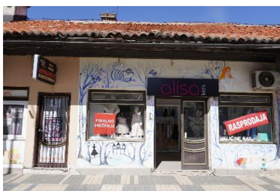
Изглед Занатског центра - локал “Алиса”, поглед из правца Булеvara Ослобођења - непримерени изглед рекламе - неодговарајући изглед и материјализација столарије (прозора и врата) - неодговарајућа позиција спољне јединице клима уређаја - непримерена боја фасадних равни
