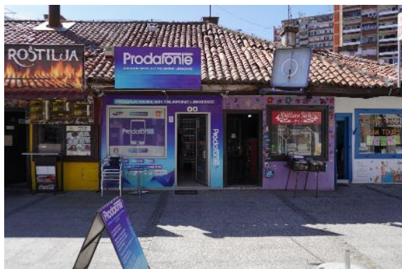
Изглед локала “Prodafonle” и “Књижара Стошић” д.о.о., поглед из правца пешачке зоне - непримерени и предимензионисани изглед рекламе - неодговарајућа позиција спољне јединице клима уређаја - неодговарајући изглед и материјализација столарије (прозора и врата)
