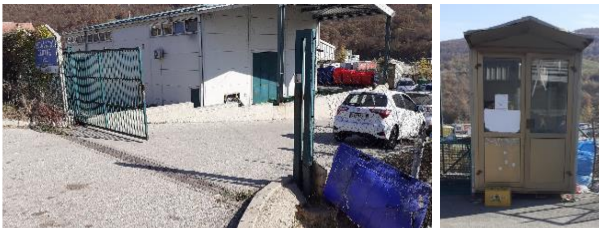
Slika 6.1-3. Ulazna kapija za pristup reciklažnom centru u Novom Pazaru (levo) i portirnica (desno)
