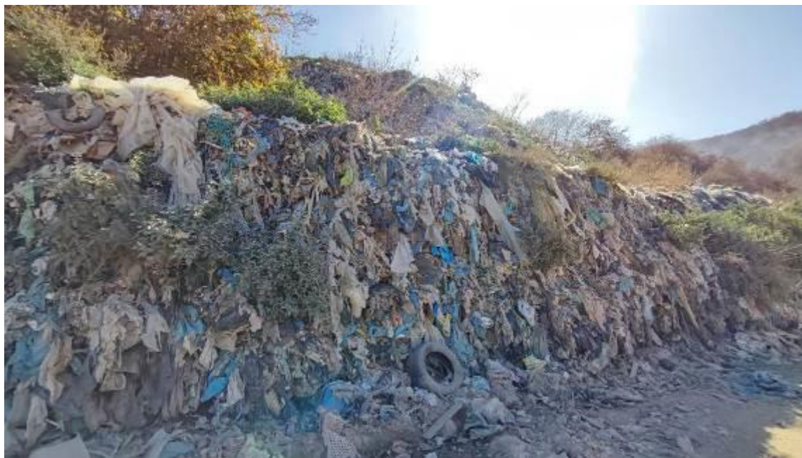
Slika 4.6-5. Sloj otpada nastao posle sabijanja i ravnjanja na deponiji Golo brdo
