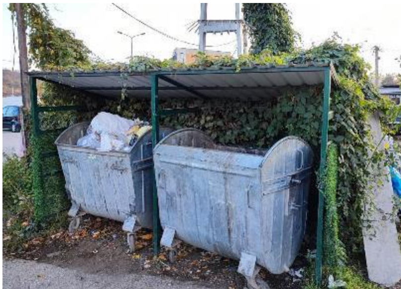
Slika 4.4.1-1. Kontejneri za mešani komunalni otpad od 1,1 m 3 , delimično ograđeni i natkriveni.
