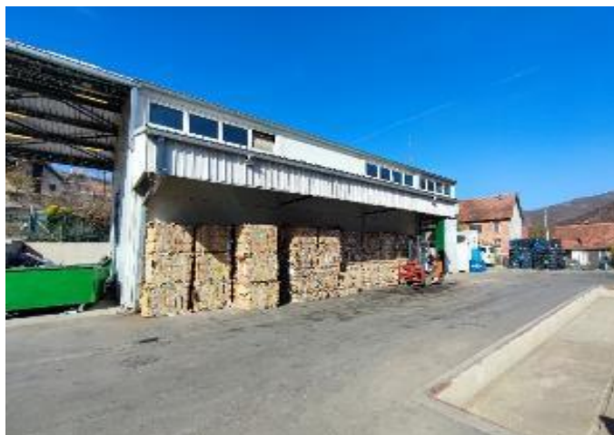
Slika 6.1.-2. Hala za reciklažu sa nadstrešnicama i telo (prijemno-otpremna zona) reciklažnog centra u Novom Pazaru, naselje Blaževo
