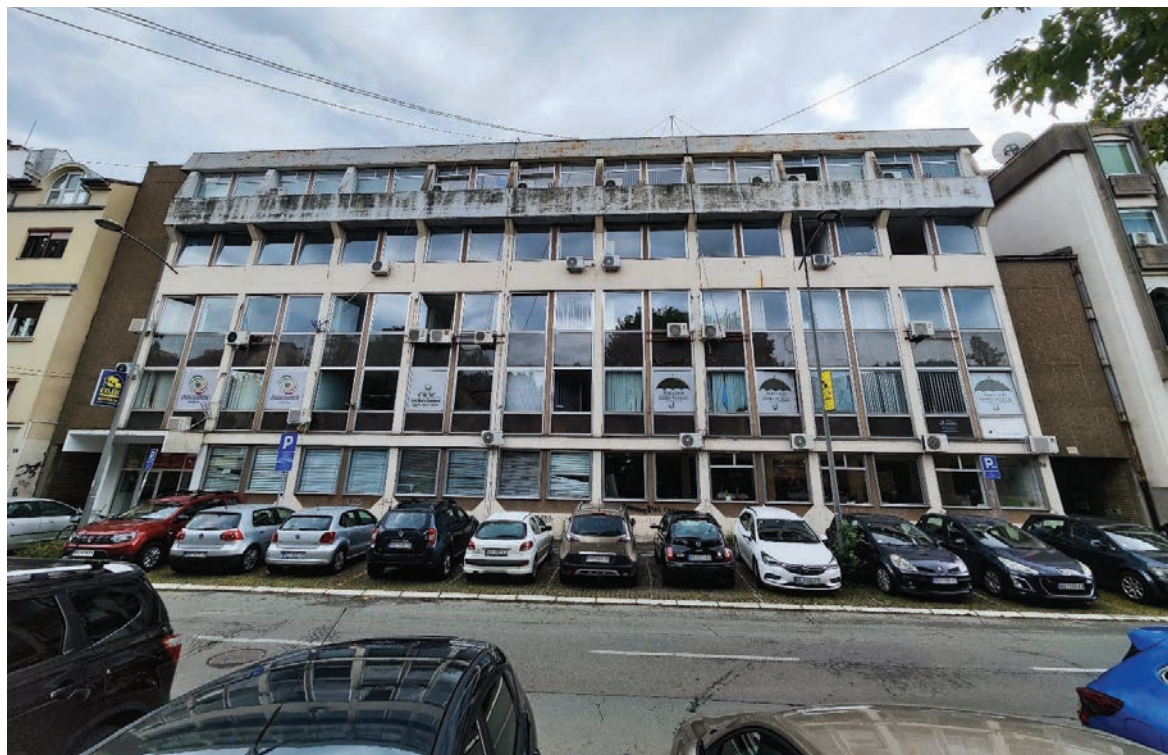
Слика 5 - Изглед спољних зидова објекта
