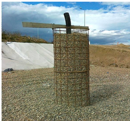
Слика 4.4 Изглед једног вентилационог бунара (биотрна)
